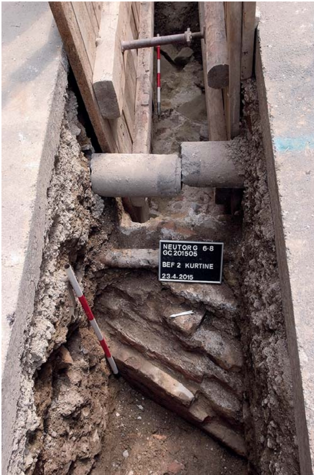
Abb. 2: Kurtine Bef.-Nr. 2 mit Ziegelvorblendung innerhalb der Wasserrohrkühnette vor Neutorgasse 8, Blickrichtung Südosten. (Foto: Stadtarchäologie Wien)
