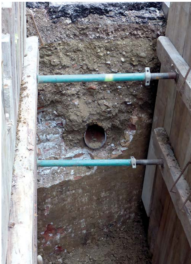
Abb. 2: Künette vor Hohenstaufengasse 12, Ziegelmauerwerk der Elendbastion, Blickrichtung Süden. (Foto: H. Krause)
