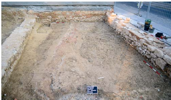
Abb. 12: Neuzeitlicher Straßenaufbau mit Schotterung Bef.-Nr. 12 und Unterbau Bef.-Nr. 13, Blickrichtung Westen. (Foto: Stadtarchäologie Wien)
