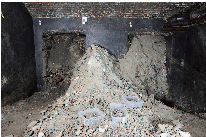
Abb. 2: Südmauer des Eiskellers mit den Nischen und Anschüttungen zu Beginn der Dokumentationsarbeiten. (Foto: L. Rastl)
