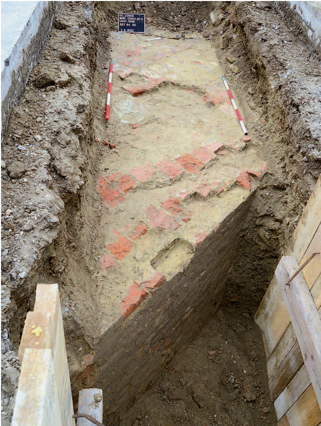
Abb. 3: Bef.-Nr. 65, Kurtinenmauer an der Nordseite der Löblbastion, Blick nach Südosten. (Foto: Stadtarchäologie Wien)
