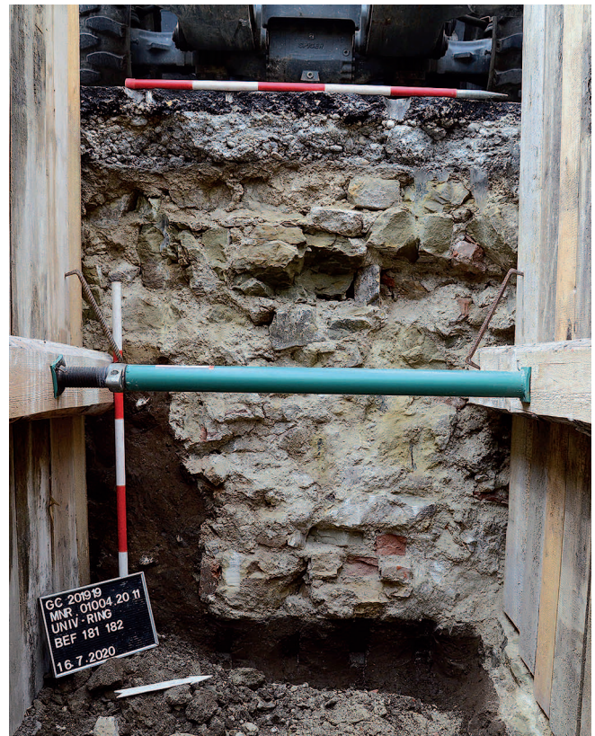
Abb. 6: Mauerwerk des Kavaliere Bef.-Nr. 182 an der Südseite der Löblbastei über Planierschicht Bef.-Nr. 181. (Foto: Stadtarchäologie Wien)
