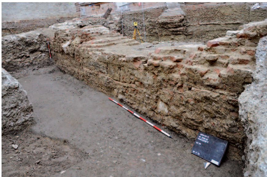
Abb. 13: Mauer Bef.-Nr. 35: Südwestliche Fundamentmauer der Reitschule des Herzogs Albert von Sachsen-Teschen. (Foto: Stadtarchäologie Wien/Novetus GmbH)
