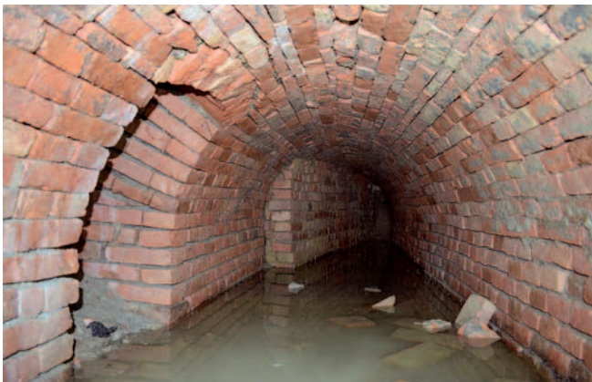
Abb. 3: Wien 6, vor Hofmühlgasse 5: Kanal Bef.-Nr. 1 nach Süden, links eine vermauerte Nische und hinten eine sekundär eingestellte Mauer. (Foto: ARDIG)
