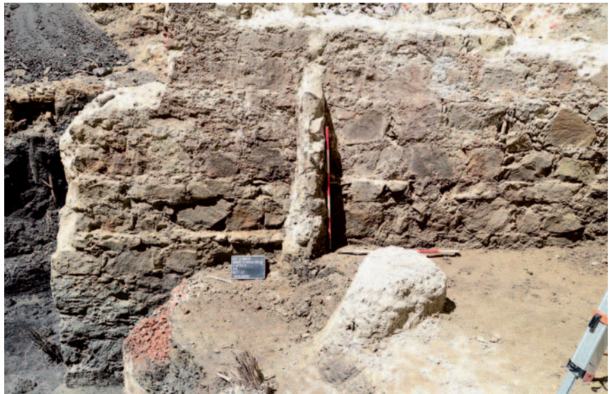
Abb. 16: Ostansicht der Strebemauer Befestigungsanlage 57 mit den deutlich sichtbaren Arbeitshöhen und dem Fundamentvorsprung Richtung Süden. (Foto: Stadtarchäologie Wien)
