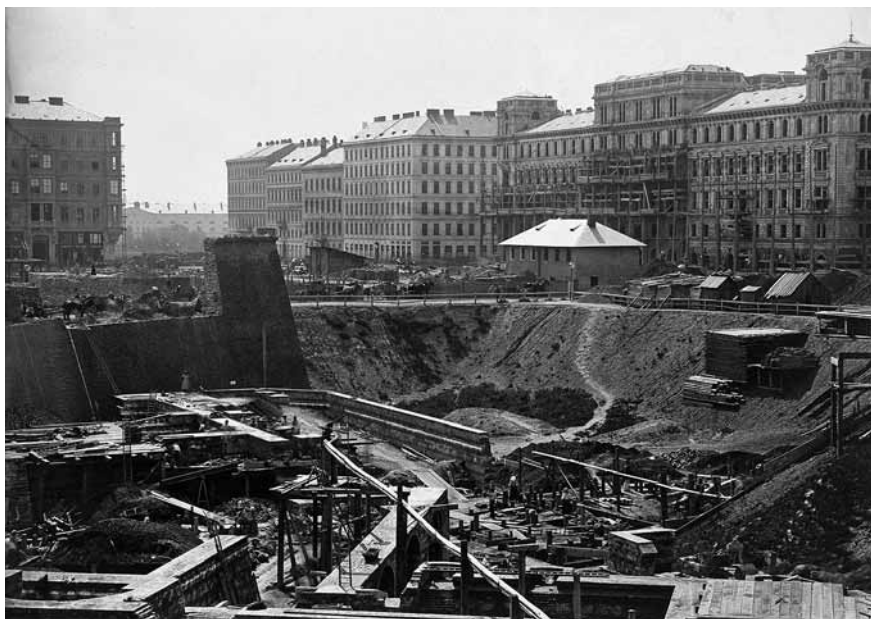
Abb. 1: Abbruch der Kärntnerbastion mit dem Rest des Festungsgrabens sowie die Fundamente des künftigen Verwaltungssitzes Erzherzog Albrechts im Vordergrund, 1863. Blick nach Südosten. (Foto: WM, Inv.-Nr. 14.512)
