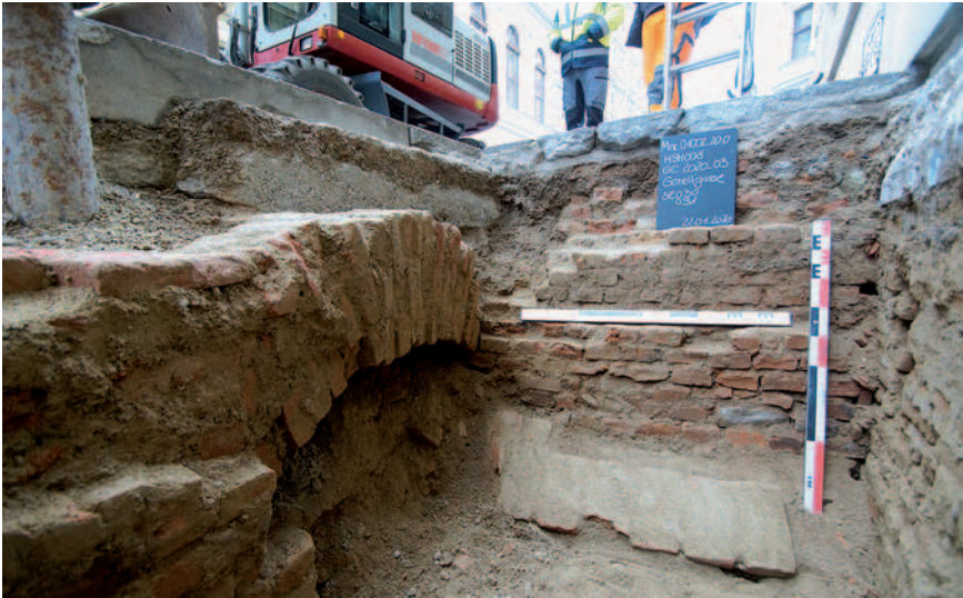
Abb. 2: Schacht im Gehsteigbereich vor Frankgasse 7: Mauerbefunde des „Roten Hauses“, Blickrichtung Osten. (Foto: archnet Bau- und Bodendenkmalpflege GmbH)
