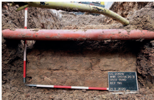
Abb. 8: Bef.-Nr. 190, Mauerrest der Bastionsface, Zustand nach der Reparatur der Sprengungen von 1809. (Foto: Stadtarchäologie Wien)
