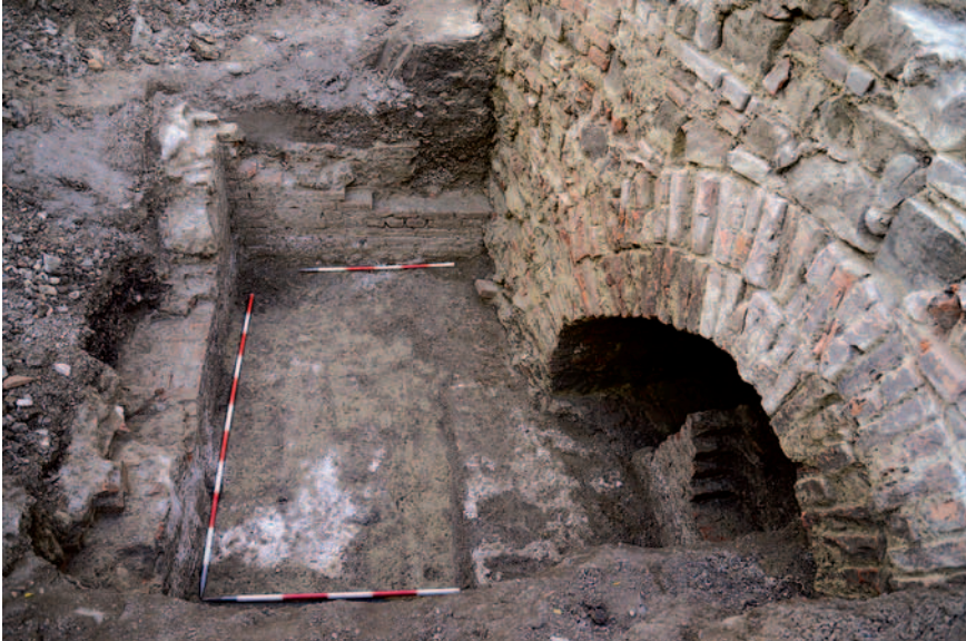
Abb. 11: Frühneuzeitlicher Keller Bef.-Nr. 226 mit Kellermauern Bef.-Nr. 535 und Resten des Bodenbelags in Form eines Mörtelstrichs. Rechts Hofmauer der Alser Kaserne (Bef.-Nr. 46), unter deren Entlastungsbogen die Kellernische zu erkennen ist, Blickrichtung Norden. (Foto: Stadtarchäologie Wien)
