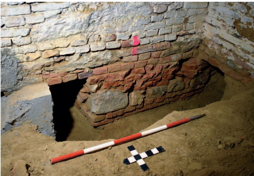
Abb. 2: Westseite von Mischmauerwerk Bef.-Nr. 7. (Foto: ARDIG)
