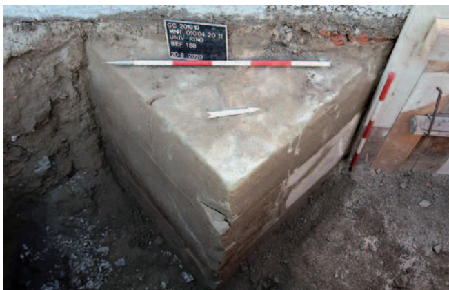
Abb. 7: Bef.-Nr. 188, im ursprünglichen Zustand erhaltene Ecke zum Flankenhof der zwischen 1544 und 1548 errichteten „Neuen Bastei“. (Foto: Stadtarchäologie Wien)
