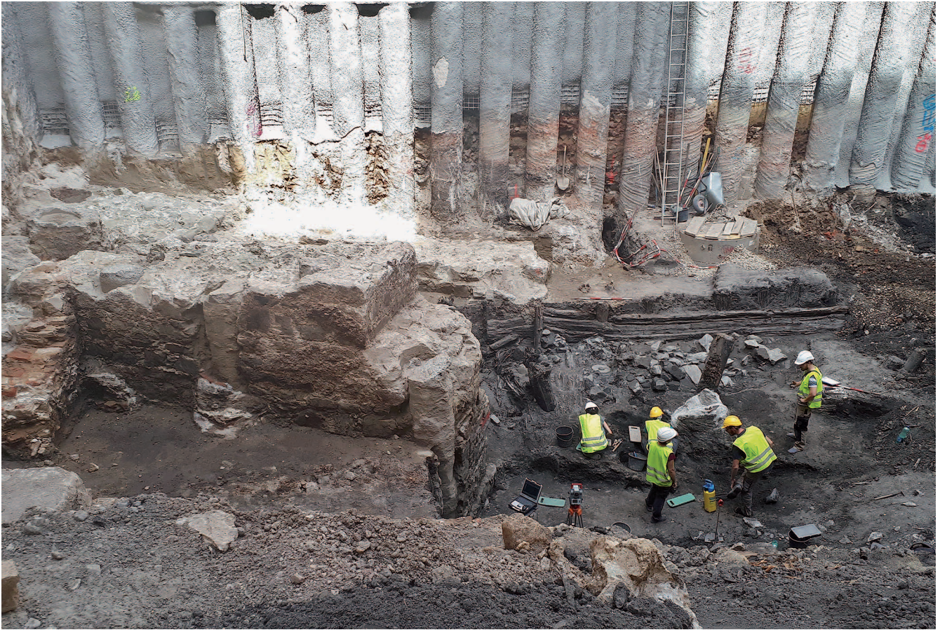
Abb. 1: Wien 1, Werdertorgasse 6. Links Reste der frühneuzeitlichen Neutorbastion, rechts ein Teil der spätmittelalterlichen Uferbefestigung, nach Nordosten. (Foto: C. Litschauer)
