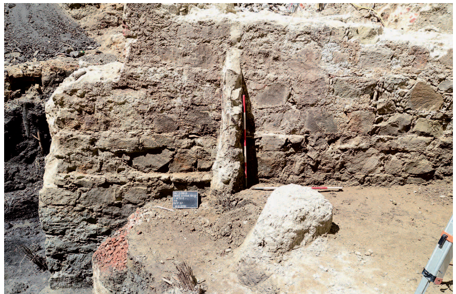
Abb. 16: Ostansicht der Strebemauer Bef.-Nr. 57 mit den deutlich sichtbaren Arbeitshöhen und dem Fundamentvorsprung Richtung Süden. (Foto: Stadtarchäologie Wien)
