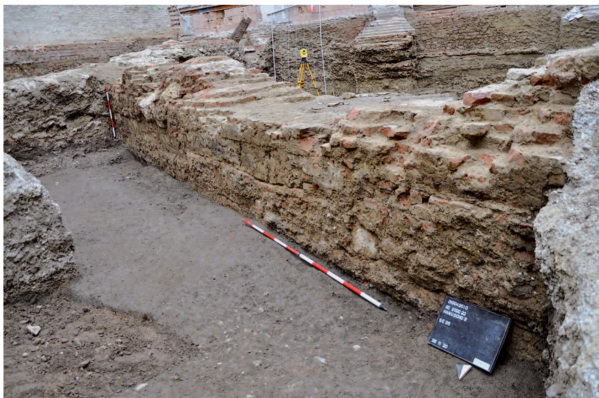
Abb. 13: Mauer Bef.-Nr. 35: Südwestliche Fundamentmauer der Reitschule des Herzogs Albert von Sachsen-Teschen. (Foto: Stadtarchäologie Wien/Novetus GmbH)
