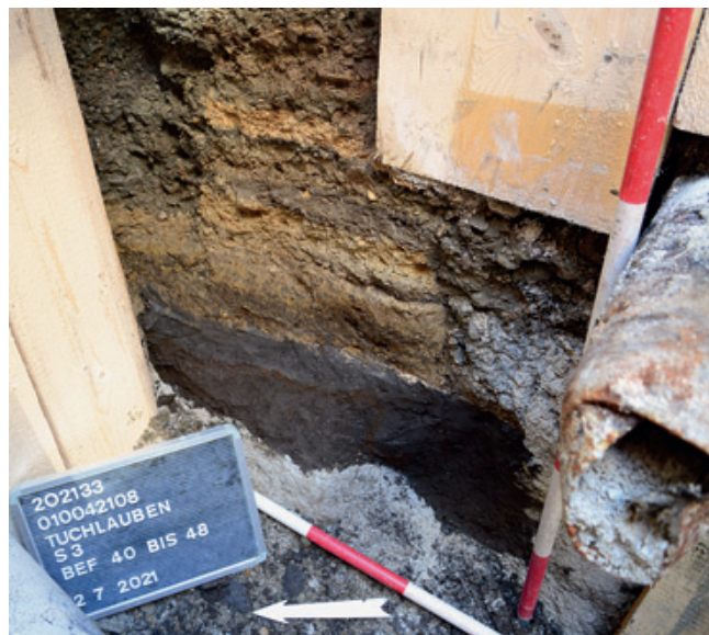
Abb. 11: Römerzeitliche Gehniveaus Bef.-Nr. 40–47 über der humosen Vegetationsschicht Bef.-Nr. 48 in der östlichen porticus der via decumana im Südost-Profil von S3. (Foto: Stadtarchäologie Wien)
