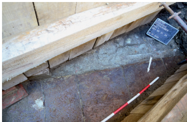
Abb. 9: Kanal mit Seitenmauer Bef.-Nr. 21 und der Sohle aus Steinplatten Bef.-Nr. 24 vor Tuchlauben 22. (Foto: Stadtarchäologie Wien)
