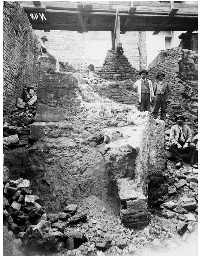
Abb. 12: Tuchlauben 13, 1912 aufgefundener Steinpfeiler (PF2) im Mauerverband mit M1 und Korridor zwischen M2 und M3 (rechts). (Foto: HMW Inv. Nr. MV 16114/4)
