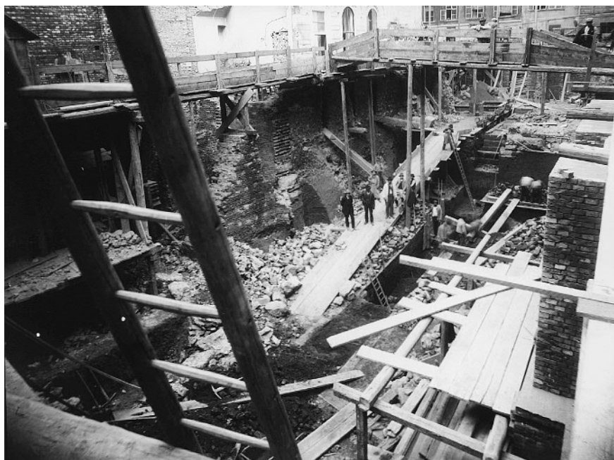
Abb. 13: Überblicksfoto über die Baustelle beim Hausumbau Tuchlauben 13, 1912, Richtung Westen gegen die Kleeblattgasse. (Foto: HMW Inv. Nr. MV 16114/1)
