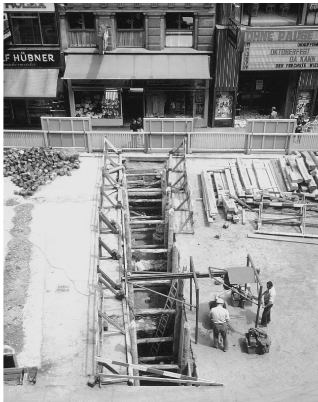
Abb. 5: Wien 1, Graben (1974) – Blick über den Schnitt von Süden. (Foto: O. Harl)
