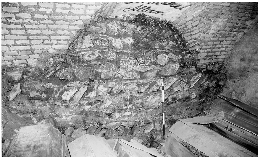
Abb. 2: Michaelerkirche. Hochmittelalterliches Fundamentmauerwerk im Bereich des nördlichen Seitenschiffes. (Foto: G. Reichhalter)
