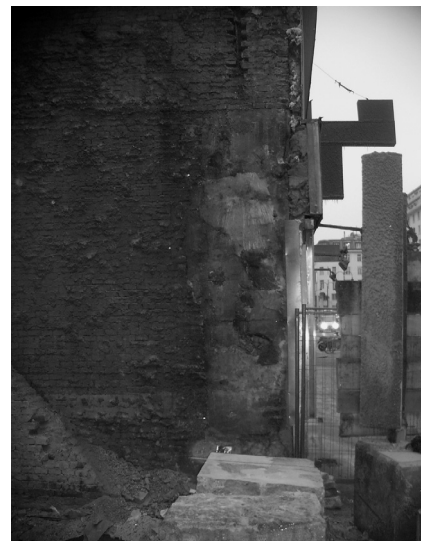
Abb. 4: Römische Quader als Eckverstärkung des Hauses Lichtensteg 5/Bauernmarkt 18. (Foto: M. Mosser)
