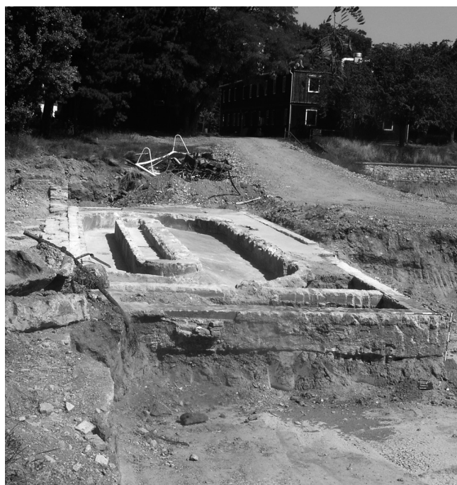
Abb. 5: Ruderbeckenanlage: Blick nach Osten. (Foto: C. Litschauer)
