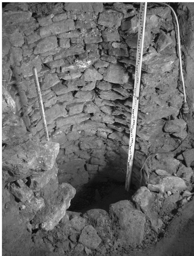
Abb. 2: Brunnenschacht, aus Bruchsteinen errichtet, in Raum 1. (Foto: I. Mader)
