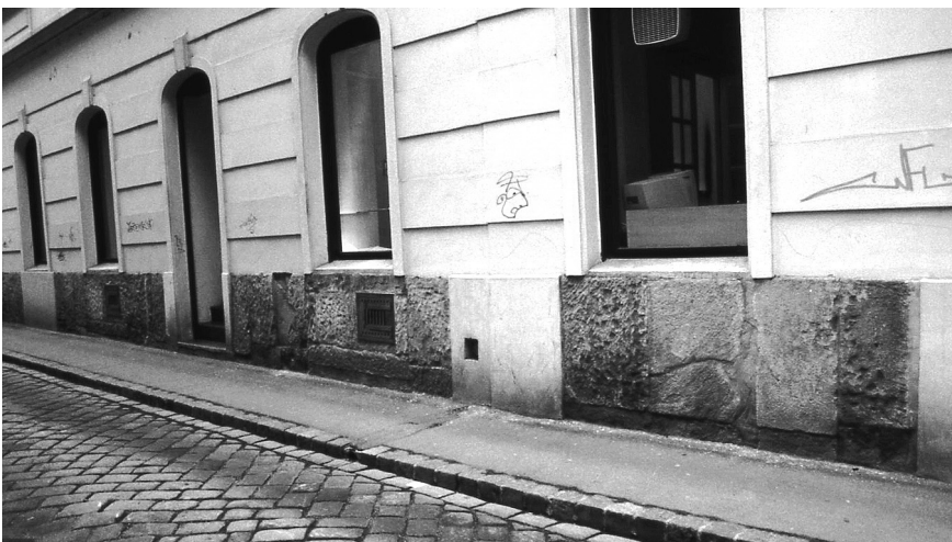
Abb. 6: Mit Steinplatten verkleideter Sockel des Hauses Salvatorgasse 9–11/Stoß im Himmel 3. (Foto: M. Mosser)
