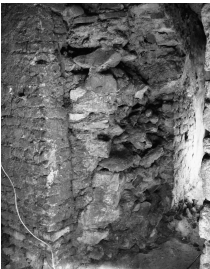
Abb. 3: Römisches Gussmauerwerk in Abschnitt A unter der Kirche Maria am Gestade. (Foto: M. Mosser)
