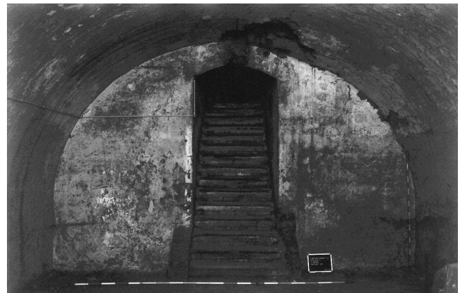
Abb. 2: Neuer Markt 14, Keller 1, Westwand mit Eingang. (Foto: C. P. Huber)
