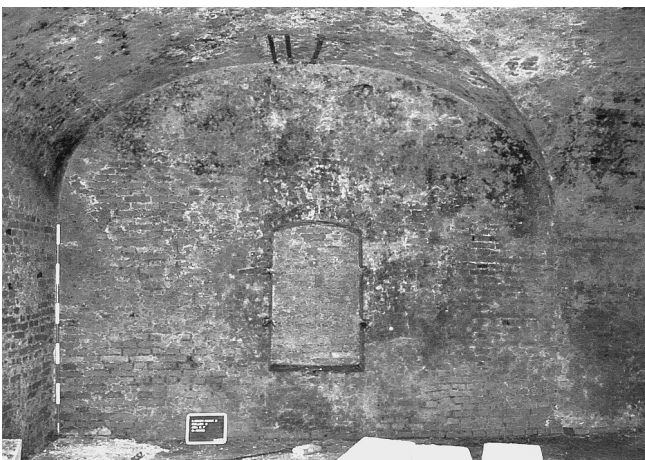
Abb. 4: Neuer Markt 2, Keller 2, Nordwand mit Nische, Stichkappe und an Keller 1 angesetzter Mauer. (Foto: C. P. Huber)
