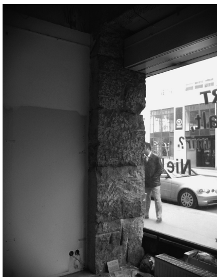
Abb. 2: Übereinandergesetzte Quadersteine im ehemaligen Verkaufsraum des Hauses Kramergasse 13/Lichtensteg 3. (Foto: M. Mosser)
