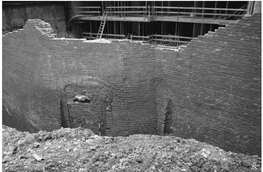
Abb. 2: Reste der Kontereskarpe vom ehemaligen Stadtgraben aus gesehen, Blick nach Osten. In der Bildmitte die vermauerte Türöffnung. (Foto: G. Reichhalter)
