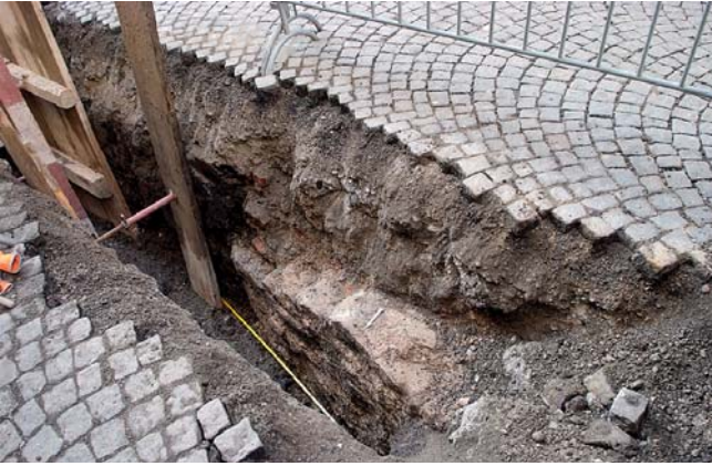
Abb. 2: Mischmauerwerk Bef.-Nr. 4 vor Sterngasse 8, Blickrichtung Süd-osten. (Foto: Stadtarchäologie Wien)
